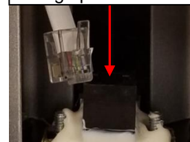
Câble de cellule de charge pas connecté
